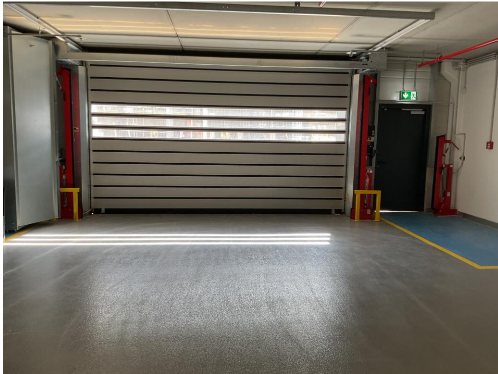
Abb. 13-14: Geteilte Löschwasserbarrieren bei geringer Deckenhöhe
