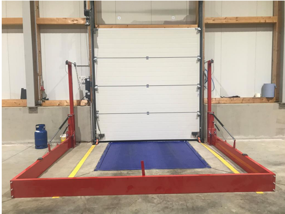
Abb. 11-12: Löschwasserbarrieren für Warentore
